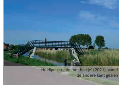
Huidige situatie 'het balkje' (2021), vanaf de andere kant gezien.
